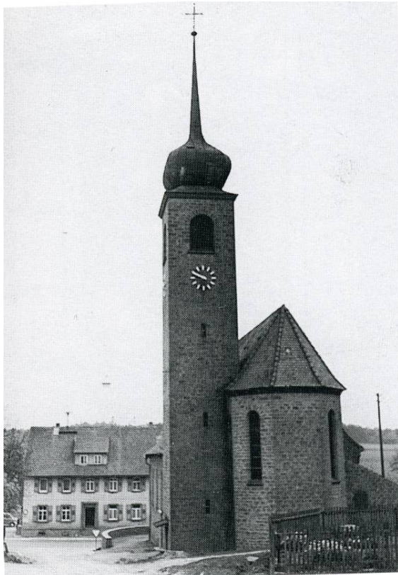
Die neu erbaute Kirche
